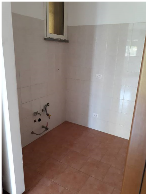
Vista angolo cottura e disimpegno Notte
